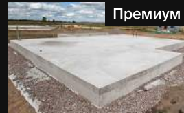
Монолитная плита
