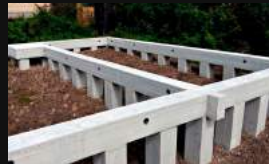
Бетонный ростверк на сваях
