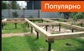
Железобетонные или винтовые сваи
